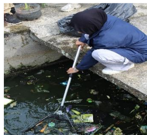
Gambar 1. Proses Pembersihan Drainase Kotor
