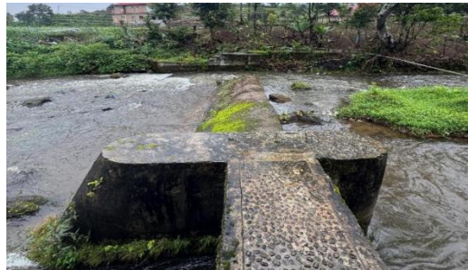
Fig. 6. Weir of the Bawah Gunung Irrigation Area
