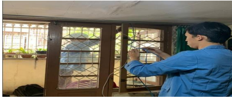
Sumber: Mohammad dzulfikar, 2022 Gambar IV.8. Penarikan Kabel LAN
