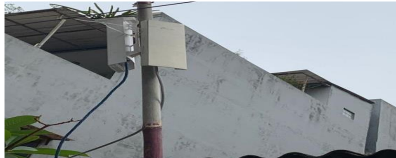
Sumber: Mohammad dzulfikar, 2022 Gambar IV.10 Hasil Instalasi TP Link CPE22
