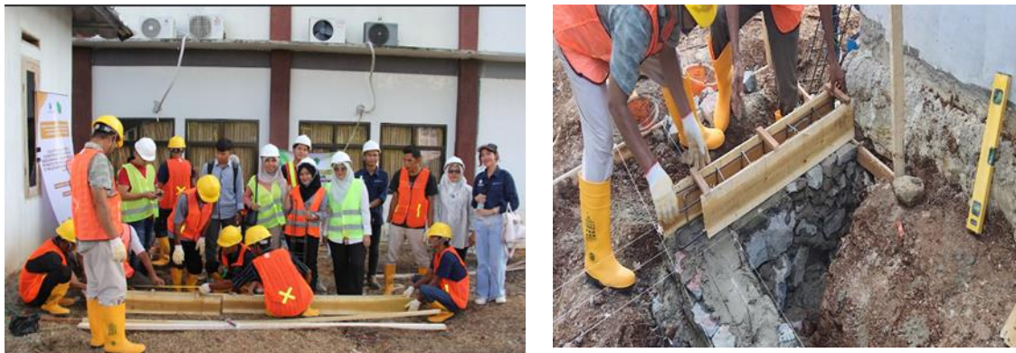
Gambar 7. Pabrikasi Bakesting dan Pemasangannya
