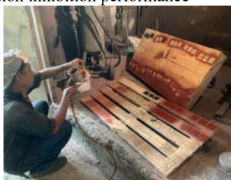
Fig 3. Epoxy Primer Painting
