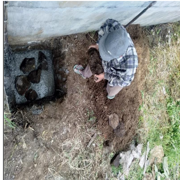
Gambar 4. Pengecoran pondasi cakar ayam pagar pengaman
