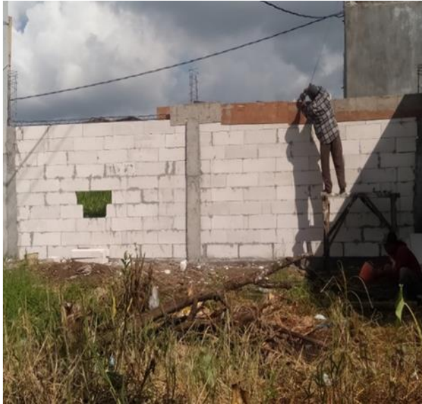
Gambar 5. KeiPemasangan dinding bata ringan
