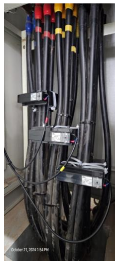
Gambar 6. Dokumentsai Pemasangan Zero Export pada Sisi Incoming PLN Sumber: Data olahan
