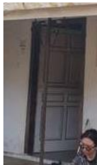
Gambar17 : Pintu dalam dan luar Pada Bangunan C Sumber : dok.penulis (2023)
