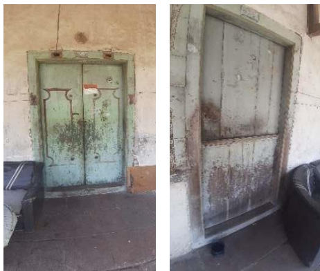
Gambar12: Pintu Bangunan B Sumber : dok.penulis (2023)
