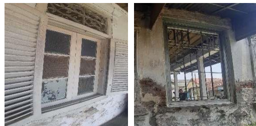
Gambar 22: Jendela Luar Pada Bangunan D Sumber : dok.penulis (2023)
