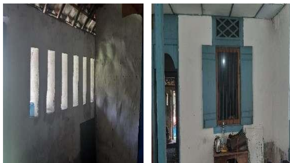
Gambar 9 : Jendela dalam Bangunan A Sumber : dok.penulis (2023)
