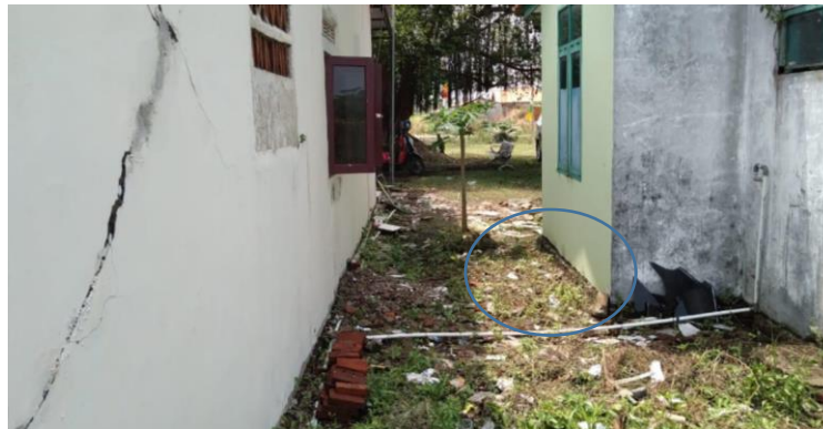
Gambar 1. Fondasi pada rumah tinggal di daerah Bendung
