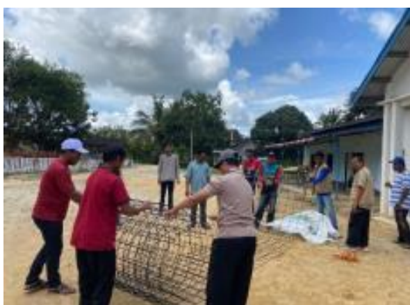
Gambar 3. Proses pemasangan wermes
