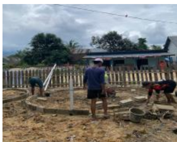
Gambar 4. Pembuatan cincin kolam
