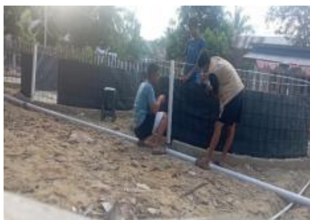
Gambar 5. Pemasangan terpal dan instalasi air
