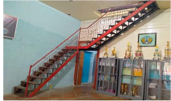
Gambar 16 : Tangga bangunan SMPN 15 Kota Cirebon Sumber: penulis, 2023
