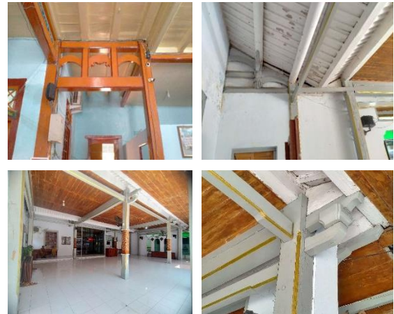
Gambar 10: Struktur menggunakan bahan kayu jati pada bangunan SMPN 15 Kota Cirebon Sumber: penulis, 2023
