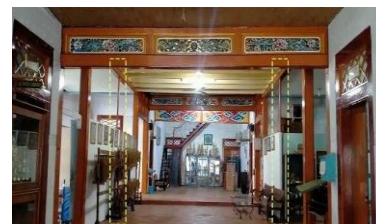
Gambar 11 : Penambahan kolom dan tiang pada bangunan SMPN 15 Kota Cirebon Sumber: penulis, 2023
