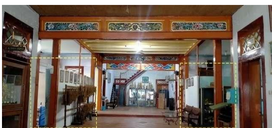
Gambar 12 : Penambahan dinding pada bangunan SMPN 15 Kota Cirebon Sumber: penulis, 2023
