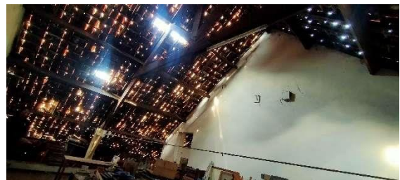
Gambar 7 : Kuda-kuda pada bangunan SMPN 15 Kota Cirebon Sumber: penulis, 2023
