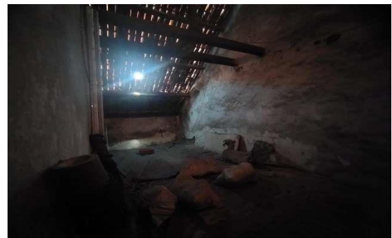
Gambar 17 : Gudang di loteng pada bangunan SMPN 15 Kota Cirebon Sumber: penulis, 2023
