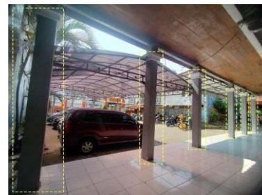
Gambar 10: Struktur menggunakan bahan kayu jati pada bangunan SMPN 15 Kota Cirebon Sumber: penulis, 2023
