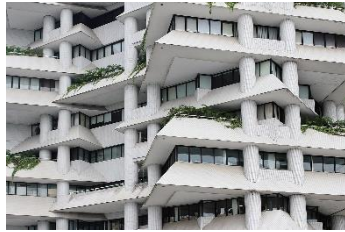
Gambar 5. Tritisasi Wisma Dharmala, Gedung Intiland, Jakarta (Sumber: archeyes.com)
