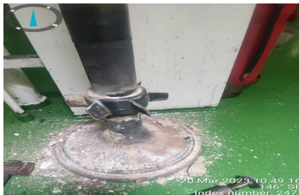
Figure 3. Kondisi spindle dengan kerak tebal
