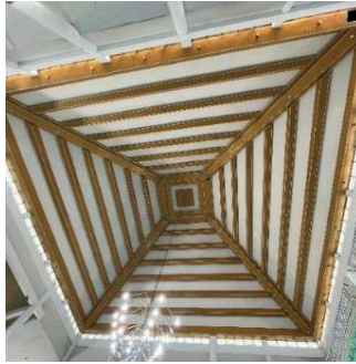
Gambar 10. Plafon Area Ibadah Masjid Agung Al-Furqan
