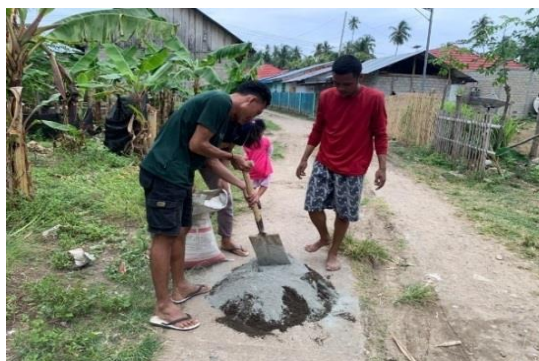
Gambar 5. Proses Pencampuran Semen untuk Pembuatan Penutup
