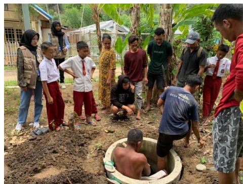
Gambar 3. Memasukkan Buis ke dalam Lubang
