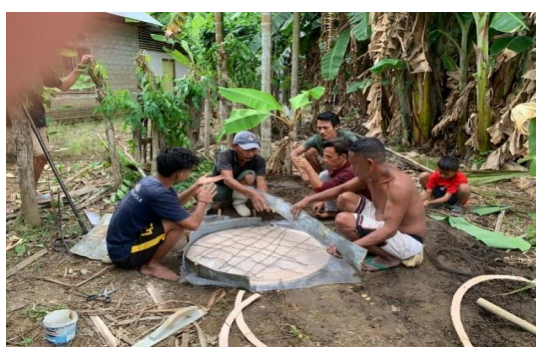
Gambar 6. Pembuatan Tutup Teba Modern
