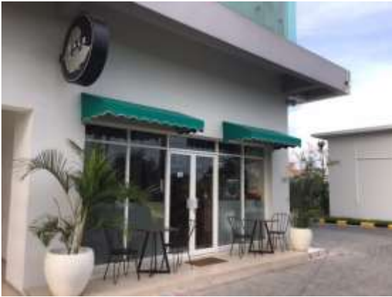
Gambar 26. Kedai kopi apartemen Bale Hinggil Surabaya. Sumber : dokumentasi pribadi.
