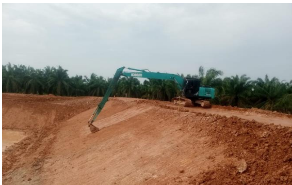
Gambar 13. Pekerjaan sloping
