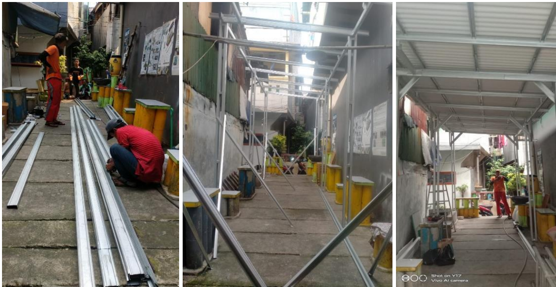
Gambar 11. Kegiatan pembangunan Kanopi
